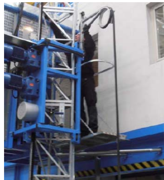
HILFSBRÜCKE FÜR VERANKERUNGSMONTAGE
